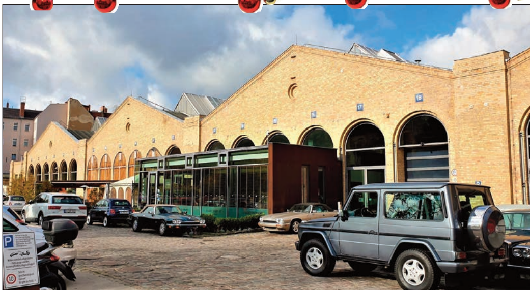
Die „Classic Remise Wiebestraße“ von außen, man erkennt noch die Formen des ehemaligen Straßenbahndepots.
