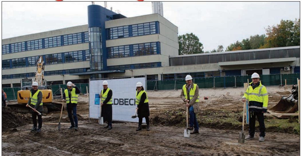
Vertreter des Projektentwicklers Projekt-Art GmbH, des Nutzers MT.DERM und des Generalübernehmers Goldbeck beim feierlichen 1. Spatenstich. Foto Copyright: GOLDBECK GmbH / MT.DERM
