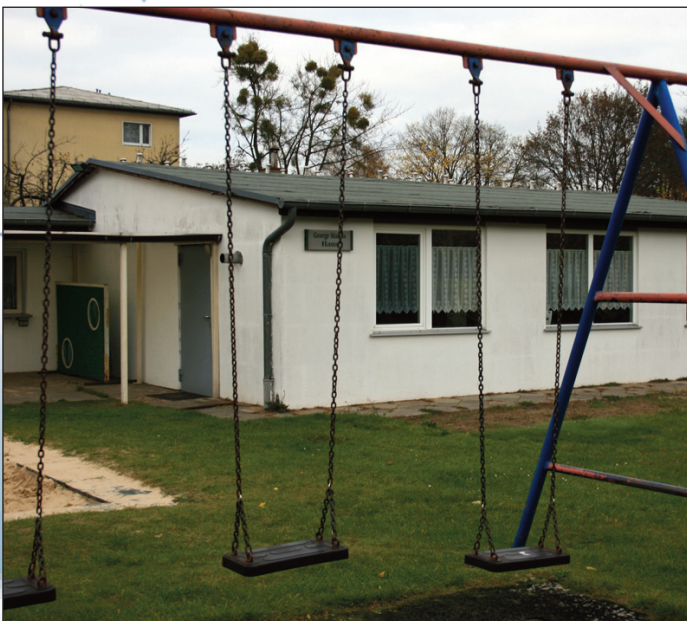
Auch das über Jahrzehnte liebevoll gepflegte Vereinsheim und der Spielplatz, auf dem immer Kinder übermütig tobten, müssen den Baggern weichen.
